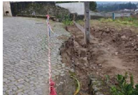
Na Rua de S. Bento, procedeu-se à reconstrução de um muro de suporte em alvenaria de granito, colapsado devido às intempéries. A intervenção revelou-se particularmente exigente, dada a escassez atual de empresas especializadas neste tipo de construção tradicional. Ainda assim, foi possível garantir a reposição da estrutura com qualidade e respeito pelo traçado original.
