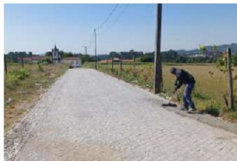
Está a decorrer a obra de repavimentação da Rua da Igreja, que inclui a substituição da antiga calçada em pedra irregular por calçada em cubo de granito. Em vários pontos, a via terá de ser alargada, implicando a construção de novos muros de vedação. Apesar de estar a avançar muito lentamente, com pausas demasiado prolongadas, causando incómodos à população, esta intervenção é essencial para melhorar a segurança e a mobilidade de todos. A Junta agradece a compreensão dos moradores.
