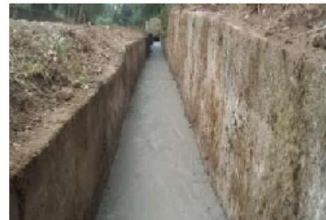
Na Rua Nova, a calha do sistema de drenagem, que se encontrava bastante danificada, foi reparada, prevenindo assim o colapso de vários muros de suporte.
